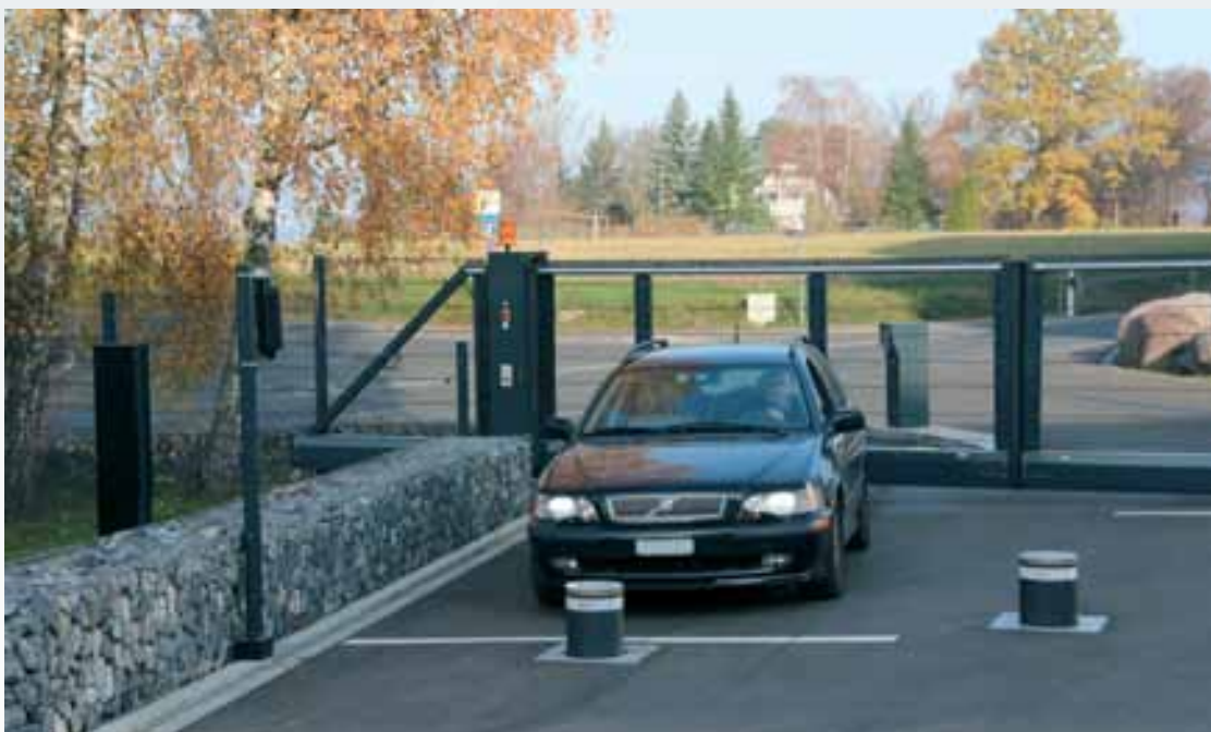
Zusammenspiel Poller- und Toranlage als Sicherheitsschleuse für PKW-Zufahrt
