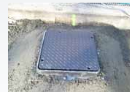
Ansicht der Fundamentarbeiten mit den vorgefertigten Pollereinbauschächten (im Lieferumfang der Consel)
