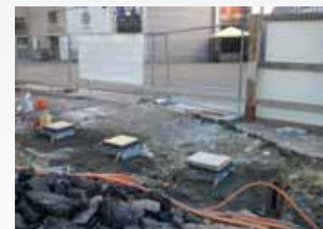
Ansicht der Fundamentarbeiten mit den vorgefertigten Pollereinbauschächten (im Lieferumfang der Consel)
